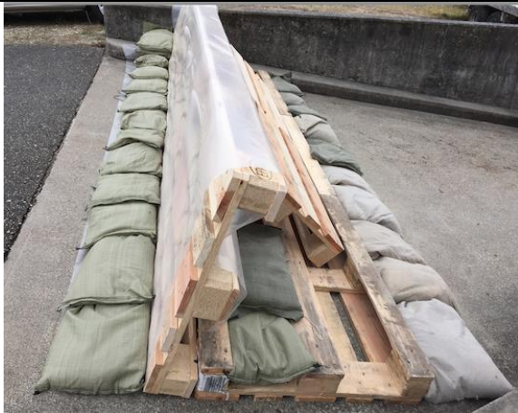
Barrage sur sol dur avec palettes, entretoise avec palettes décalées et renforcement avec des sacs de sable
