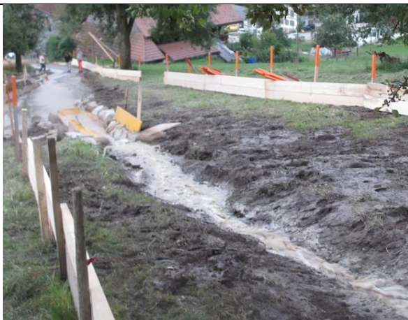
Canalisation par un barrage de planches
