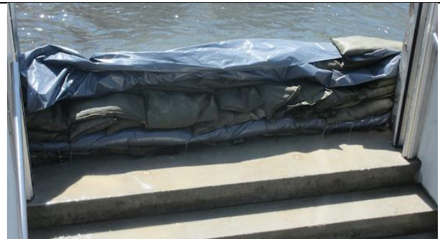
Barrage avec des sacs de sable avec plastique (« sacoches en plastique »)
