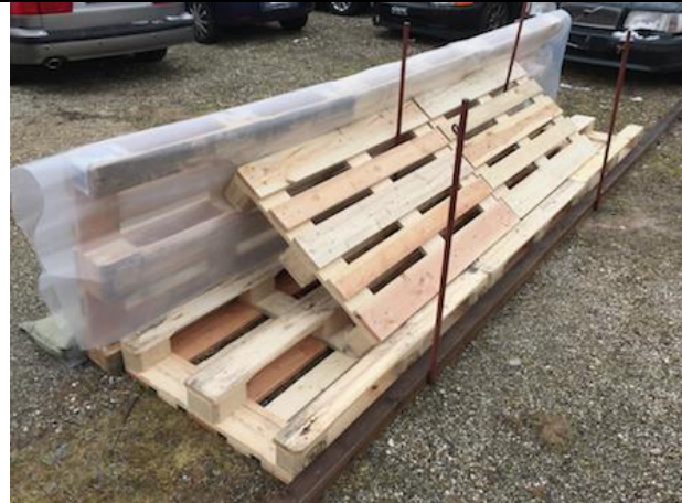
Barrage sur sol tendre avec palettes, entretoise avec palettes décalées et ancrage avec des pieux
