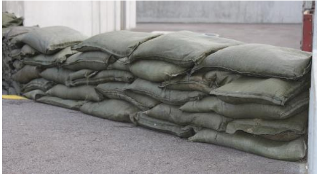
Barrage avec des sacs de sable
