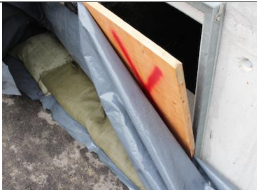
Sécurisation d'une fenêtre de cave en construction
