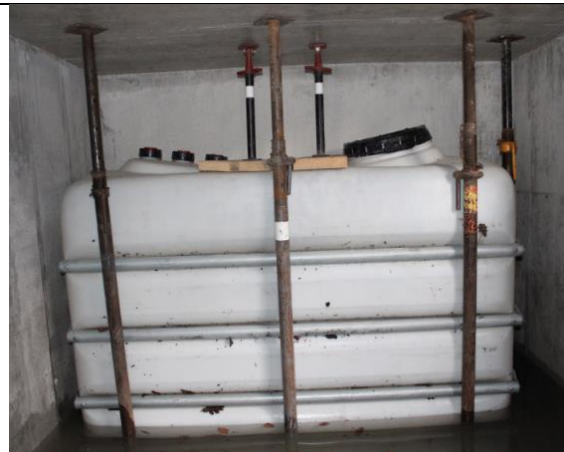
Assurance d'une citerne à mazout avec des étais
