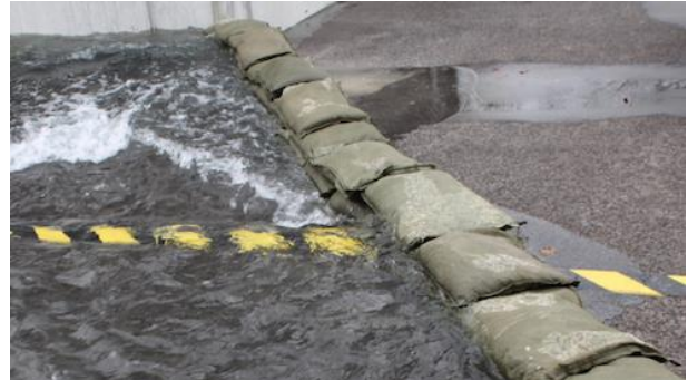
Barrage avec des sacs de sable sur une bordure
