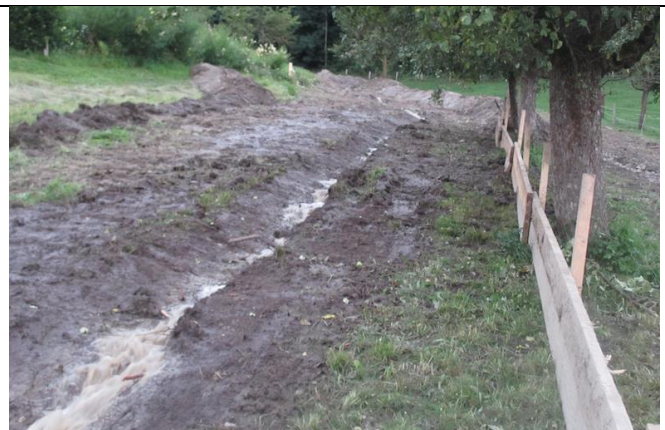
Canalisation par un barrage de planches (stabilisées par des pieux de chaque côté)
