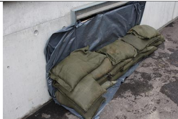
Sécurisation terminée d'une fenêtre de cave
