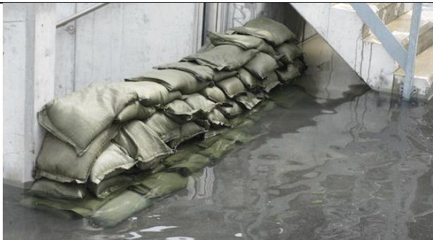
Barrage avec des sacs de sable sans plastique
