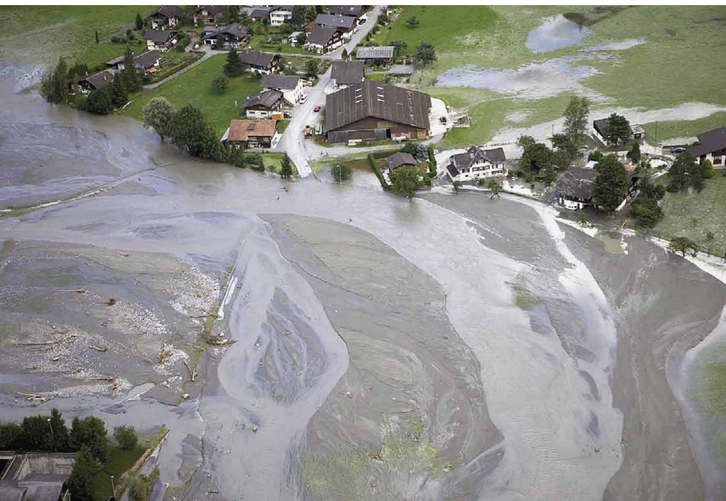
Aare-Dammbruch, Meiringen, Unwetter 2005
