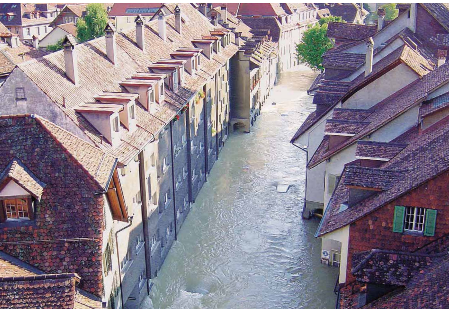
Mattequartier, Bern, Überschwemmung 1999/2005
